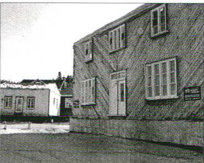
AUBERGE - Déménagé à Larouche l'automne dernier, le presbytère de Saint-Bruno deviendra une auberge. Les travaux doivent débuter bientôt.
